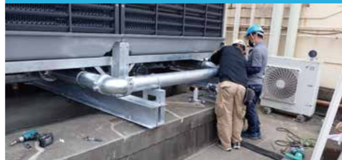
施工事例①
