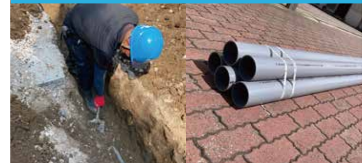
配管工事の様子
