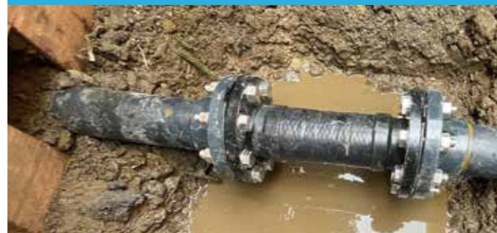
給排水工事の様子
