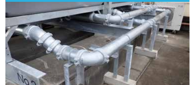
施工事例②
